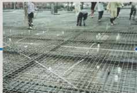
● 上層鋼網鋪設
