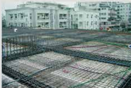
● 上層鋼網鋪設完成
