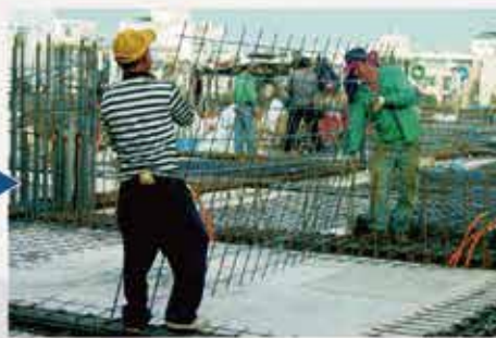
● 下層鋼網鋪設
